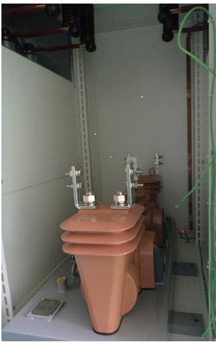
【VCT設置状況】
