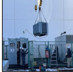
キュービクル更新工事
