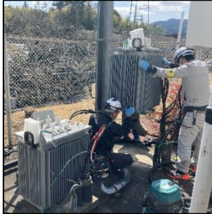
変圧器更新工事
